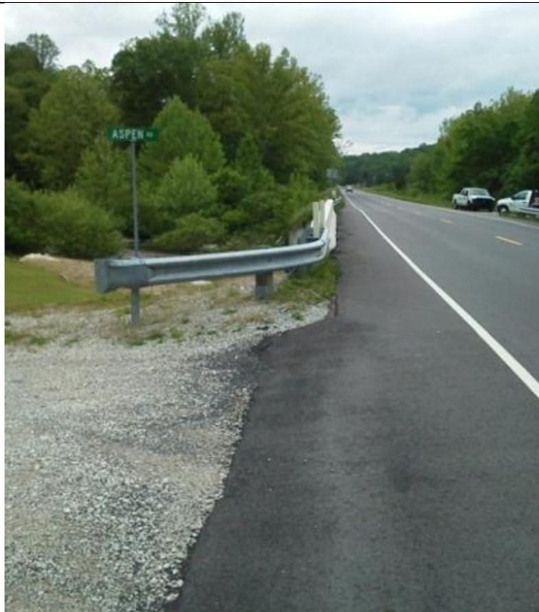
(d) Short Radius Guardrail Example from Tennessee DOT
